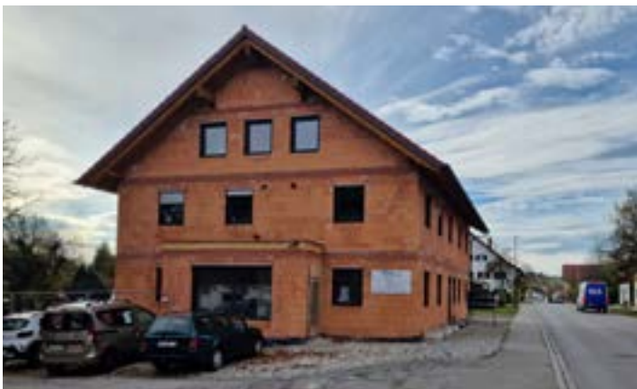
Schließung einer Baulücke in der Gemeinde Schwabsoien
