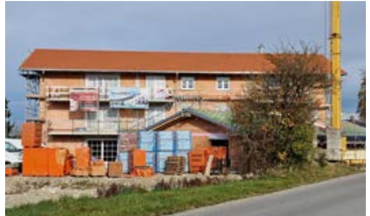
Neubau eines Mehrfamilienhauses in Kinsau
